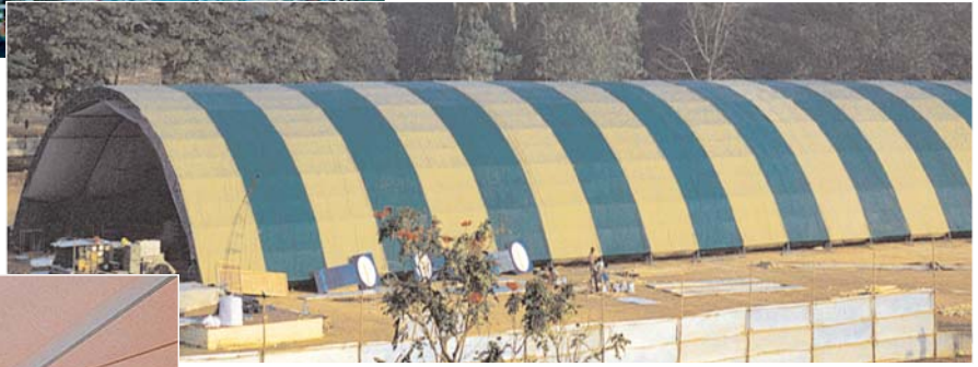
150 meter long hanger.
